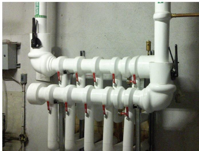
PHOTO 3 : COLLECTEURS GÉOTHERMIQUES SITUÉS DANS LA SALLE MÉCANIQUE.
