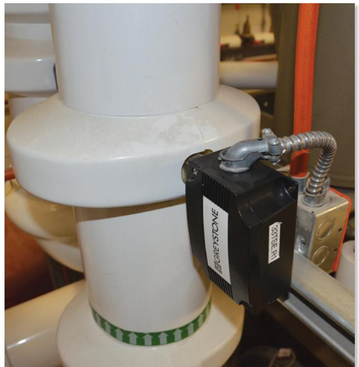
PHOTO 5 : SONDE DE TEMPÉRATURE (INSÉRÉE DANS UN Puits D'IMMERSION DANS LA TUYAUTERIE) ET SON TRANSMETTEUR DE SIGNAL ÉLECTRONIQUE.
