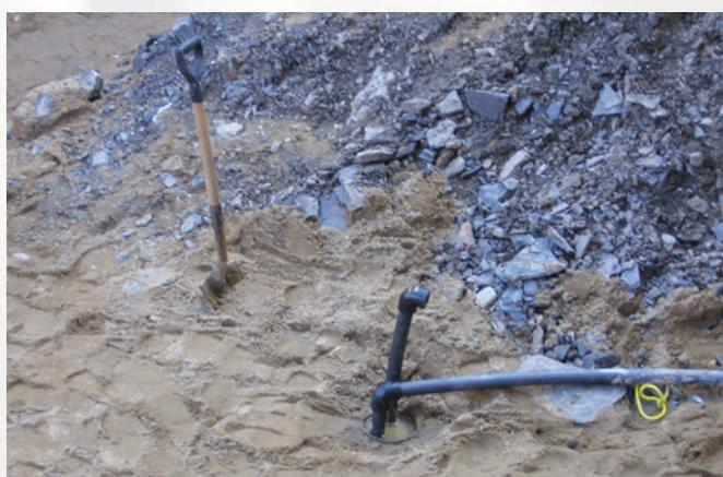
PHOTO 1 : PUIITS GÉOTHERMIQUE EN COURS DE RACCORDEMENT DANS UNE TRANCHEE EXCAVEE.
