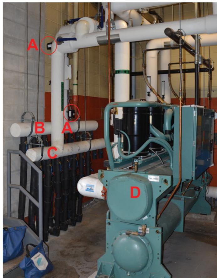
FIGURE 1 : SYSTÈME GÉOTHERMIQUE VU DE LA SALLE MÉCANIQUE
