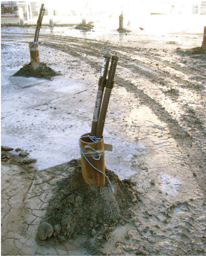
PHOTO 2 : PUIS DE GÉOTHERMIE À UNE ÉTAPE INTERMÉDIAIRE DE CONSTRUCTION (APRÈS FORAGE ET INSTALLATION DES BOUCLES DE TUYAUSERIE, MAIS AVANT L'EXCAVATION).
